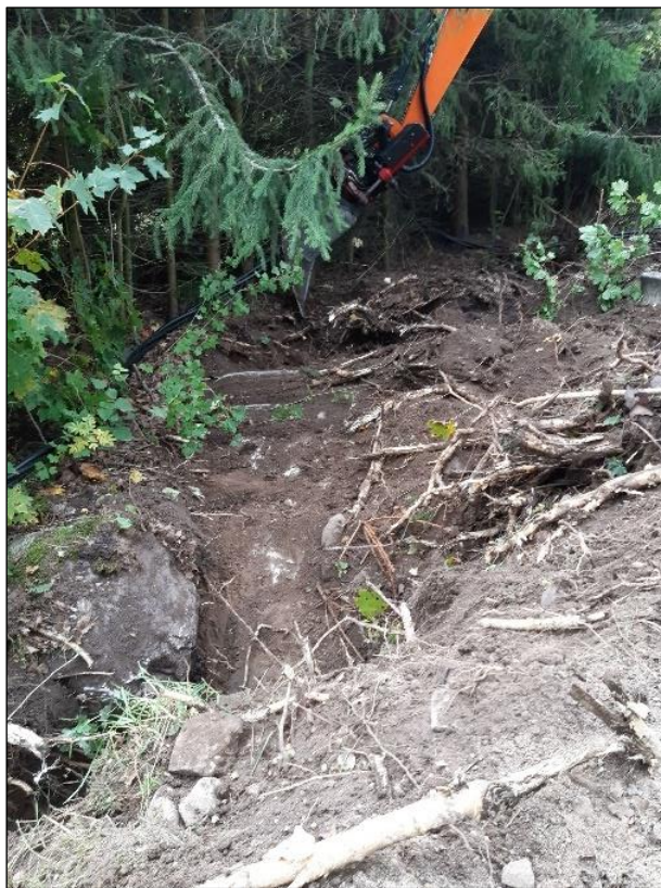
Vasen: juurakot vaikeuttivat kaivamista. Oikea: tien vierellä oli kalliota, jota kaivettiin esiin leveämmältä alueelta.
