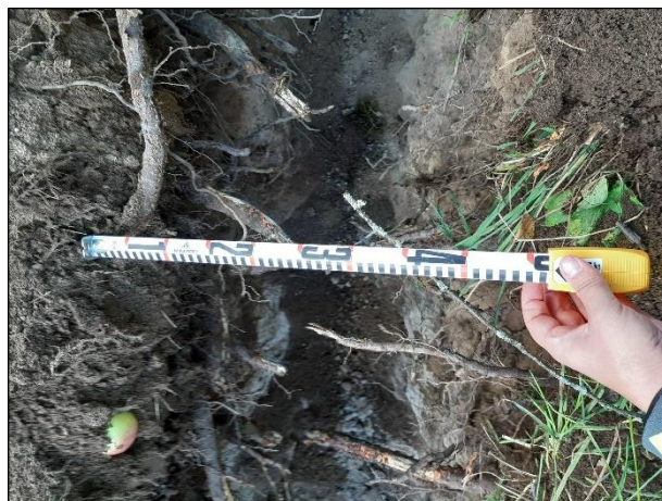
Vasen: kaapeloja kaivettiin hiekanottokuopan poikki muinaisjäätösalueen itäreunalla. Oikea: kaivannon leveys oli n. 30 – 40 cm.
