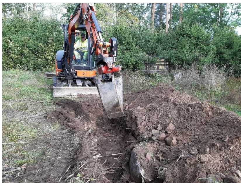
Kallio ja kivet vaikeuttivat kaapeliojan kaivuuta.
