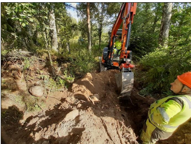
Vasen: kaapeloja kaivettiin hiekanottokuopan poikki muinaisjäätösalueen itäreunalla. Oikea: kaivannon leveys oli n. 30 – 40 cm.
