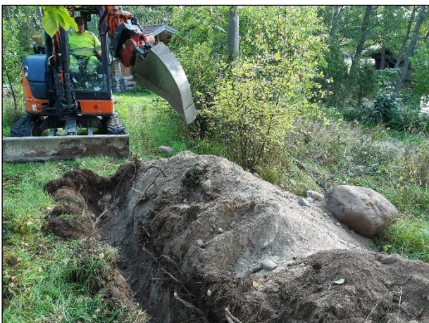
Vasen: maaperä pihan alueella oli hiekkaa, seassa oli joitakin suuria kiviä. Oikea: kaapeloja kaivettiin kahden piharakennuksen välistä, alueella oli aikaisempi kaapelikaivanto rakennusten välillä.
